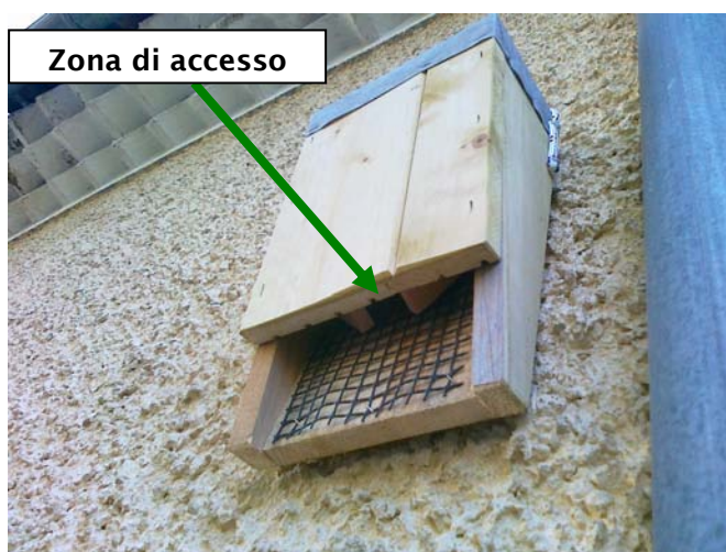
Foto delle batbox installate
